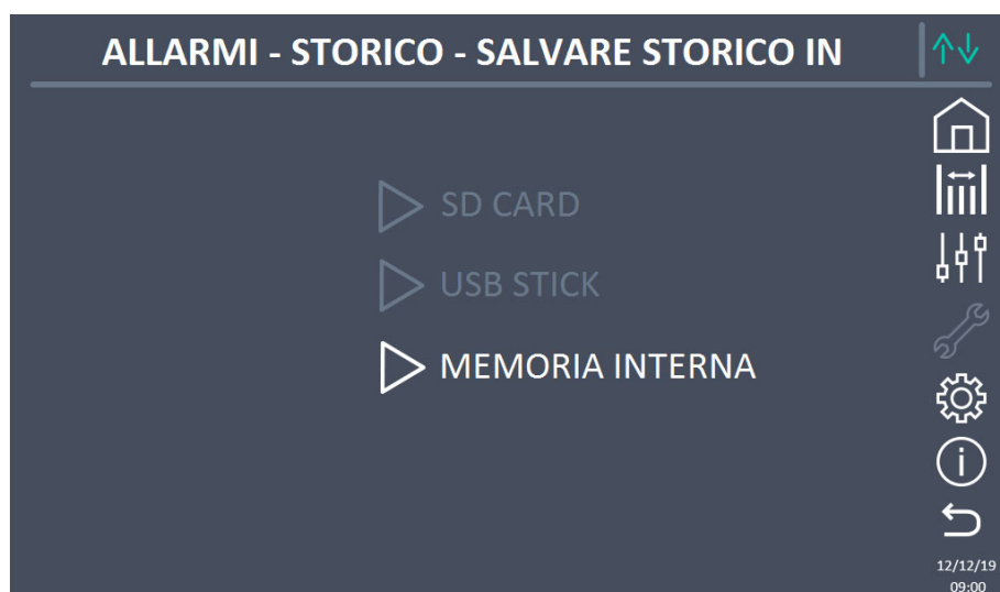
Figura 16 – Storico allarmi, salvataggio file
