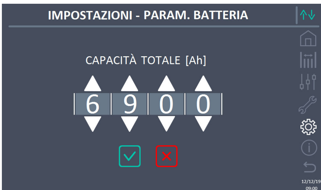
Figura 28 – Sezione IMPOSTAZIONI – CAPACITÀ BATTERIA – config. batteria unica (Sistema)
